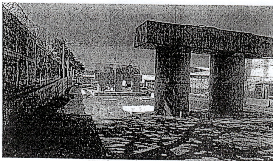
SITUACIÓN ACTUAL ÁREA NO INTERVENIDA
